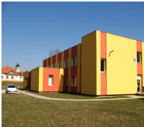
(obr. budova č.3 ambulancí po rekonstrukci)
