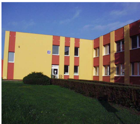
(obr. budova č.3 ambulancí po rekonstrukci)
