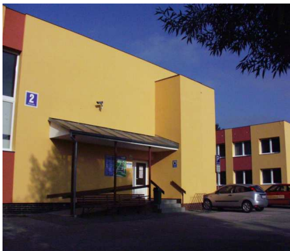
(obr. budova č.2 ambulancí po rekonstrukci)
