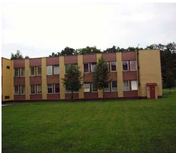
(obr. budova č.3 ambulancí před rekonstrukcí )
