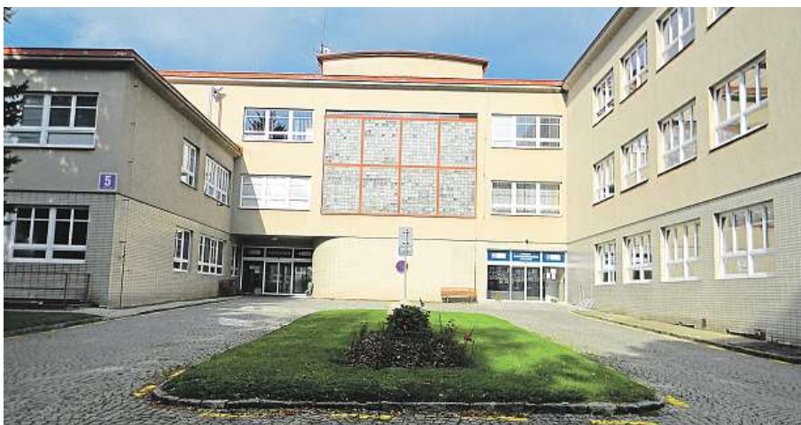
NA SPODNÍM SNÍMKU JE VIDĚT, JAK VYPADALA FASÁDA NEMOCNICE PŘED REKONSTRUKCÍ, NAHOŘE UŽ JE HOTOVO. NA PRVNÍM MÍSTĚ JE ALE VŽDY KOMFORT PACIENTŮ A SPOKOJENOST ZAMĚSTNANCŮ UVNITŘ.
